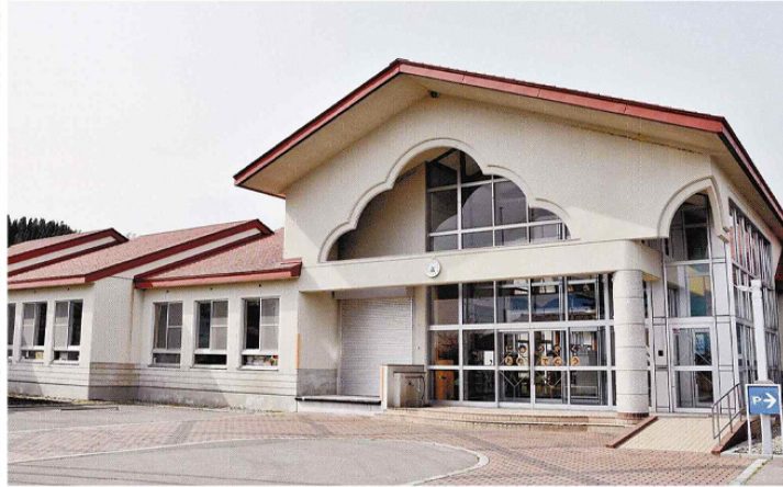
横津岳の麓に建つ現在の峠下小の校舎
