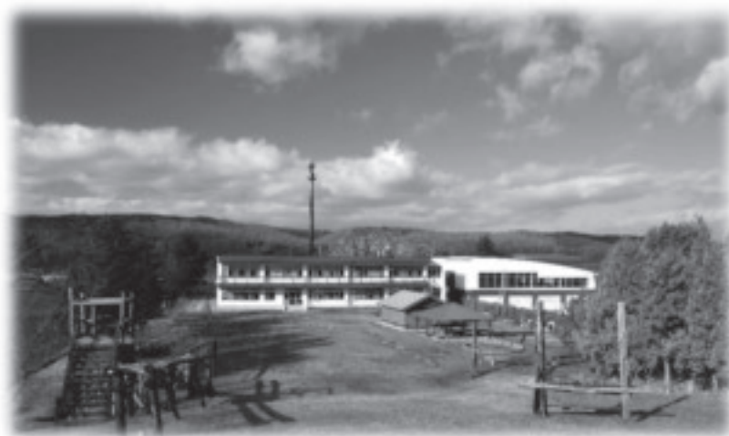
樹海学校の校舎となる現在の樹海小学校の校舎 (緑色の東屋の左側に増築し、樹海学校の校舎となる。)
