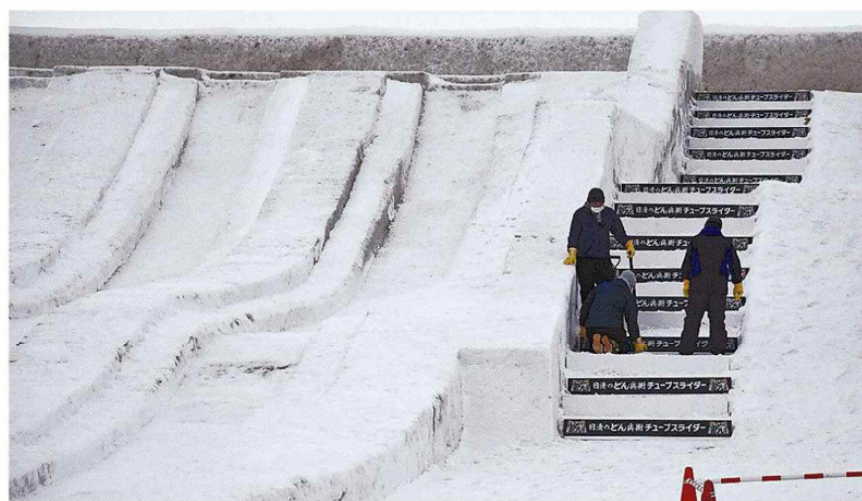
開幕を控え、チューブスライダーの補修作業などが行われた「つどーむ会場」＝30日、札幌市東区
