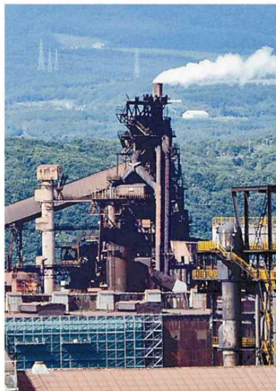
改修される日本製鉄室蘭製鉄所の高炉
