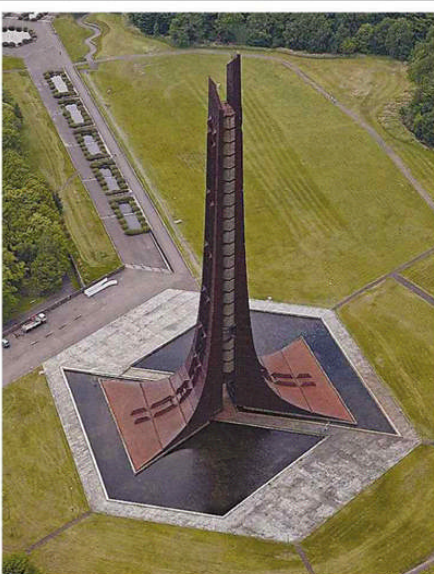
道が解体する方針を固めた北海道百年記念塔（本社ヘリから）
