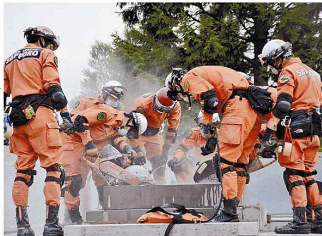
コンクリート壁を切断する訓練参加者ら
